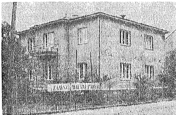
Dzisiaj budynek przedszkola. W tamtych latach — siedziba PUBP. Fotografia sprzed kilku lat.
