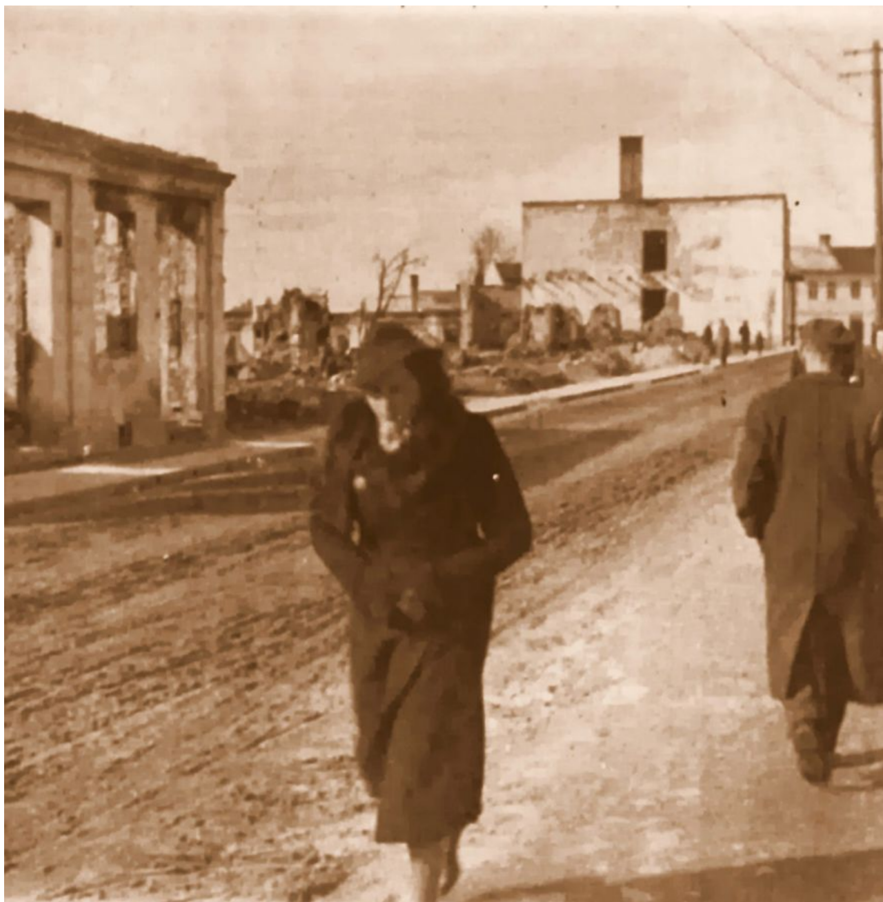
• Zniszczenia wojenne na ulicy Piłsudskiego
